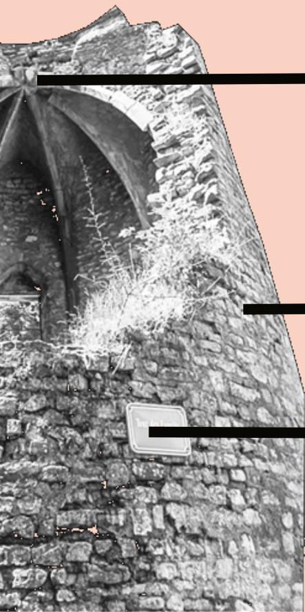
Élément de construction ajouté pour fermer une voûte, placé au sommet de celle-ci :
